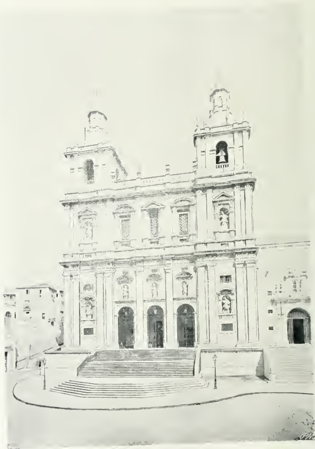
Fachada da igreja de S. Vicente (Actual)
